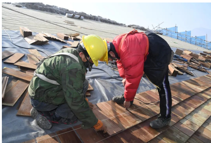
图 3.3.2 北京住总延庆冬奥村项目积极复工
